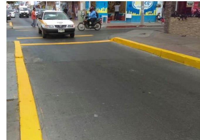
Figura Vialidad con guarnición (Se observan de color amarillo).
