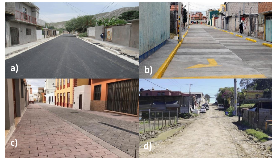
Figura a) Calle con pavimento; b) Calle con concreto; c) Calle con empedrado o adoquines; d) Calle sin recubrimiento.
