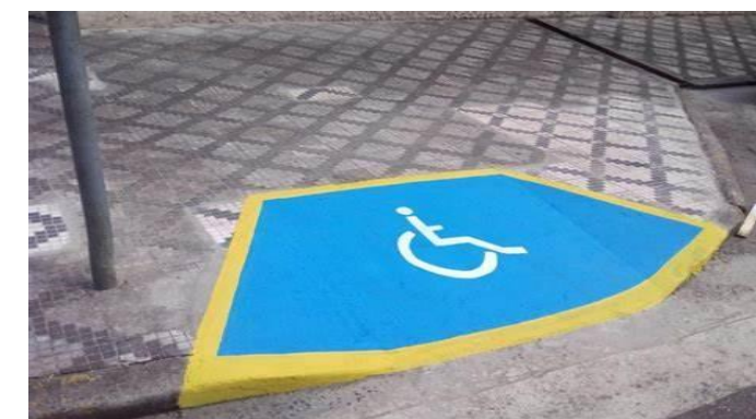
Figura 5. Banqueta con rampa para sillas de ruedas.
